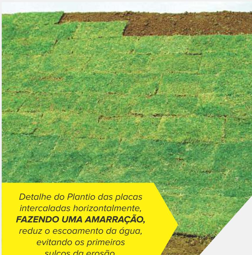
*Detalhe do Plantio das placas intercaladas horizontalmente, **FAZENDO UMA AMARRAÇÃO**, reduz o escoamento da água, evitando os primeiros sulcos da erosão.*
